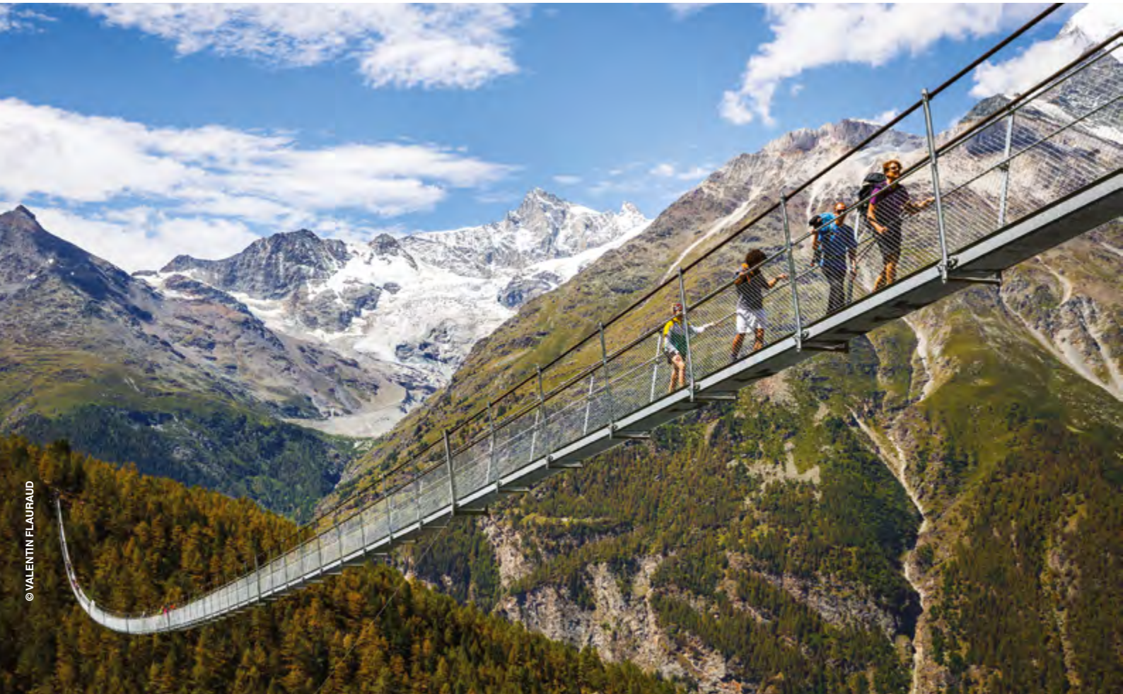
▼ PASSERELLE SUSPENDUE CHARLES KUONEN PRÈS DE ZERMATT 494 mètres : la plus longue du monde.
